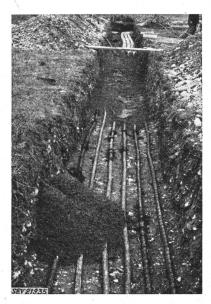
Fig. 3 Verlegung der drei Kabelstrecken von je 100 m für Dauerversuche in Dietikon
