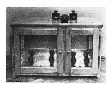
Glühlampen. Voneinander unabhängige Regulierung der Temperatur in beiden Abteilen durch verstellbare Temperaturregler. Schalter zum Ein- und Ausschalten je eines Lampenpaares, Verbindungsdose sowie Temperaturregler oben auf dem Schrank. Zuleitung dreiadrige verstärkte Apparateschnur, fest angeschlossen.
