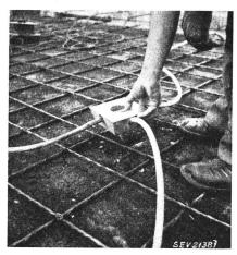
Fig. 2 Verwendung bei Lampendübeln
