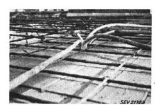
Fig. 1 Ductub-Schläuche vor dem Einbetonieren
