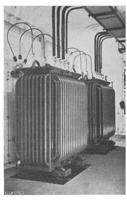
Fig. 3 Station de transformation 6400/380 V, Typ SEL Transformateurs de 300 kVA
