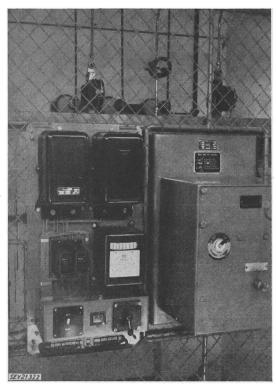
Fig. 1 Einfache Relaiskombination für automatische Kurzschlussfortschaltung und für Erdschlußsuche
