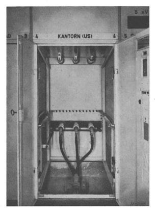
Fig. 5 Schaltfeld mit ausgefahrenem Schaltwagen
