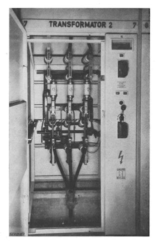
${\bf Fig.} \ 7$  Leistungstrennerschaltfeld der Transformatorenabzweigung
