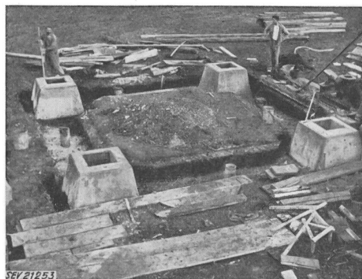
Fig. 12 Fundamentbau auf der 380-kV-Leitung Amsteg—Mettlen Rahmenfundament, Baujahr 1947
