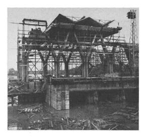
Fig. 3 Maschinenhaus-Rohbau
