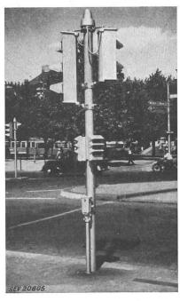
Fig. 4 Signalmast mit besonderen Signalkästchen für die Fussgänger in Zürich
