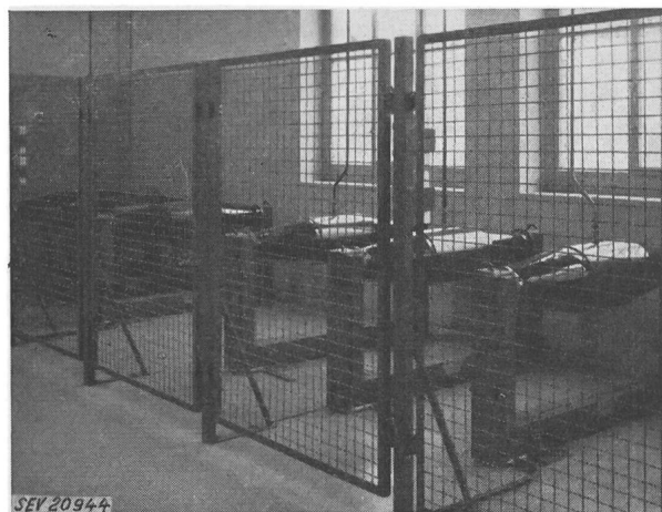
Fig. 14 Sechs Spannungswandler, Pol-Erde, 60 kV
