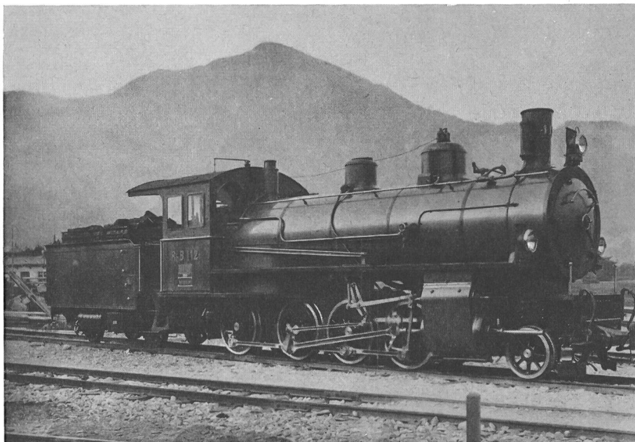
Fig. 1 4/5 gekuppelte Heissdampf-lokomotive Rh.B. Serie 101-129, mit Schlepptender; 800 PS; Gewicht total 65 t
