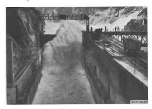
Sortie de l'évacuateur de crues rive gauche du barrage de Génissiat, vue de l'amont. Passage de 600 m<sup>1</sup>/s A comparer avec la figure 7
