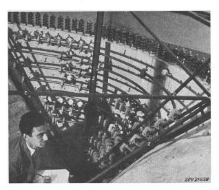
Fig. 16 Dispositif de mesure des déformations d'un modèle de barrage-voûte
