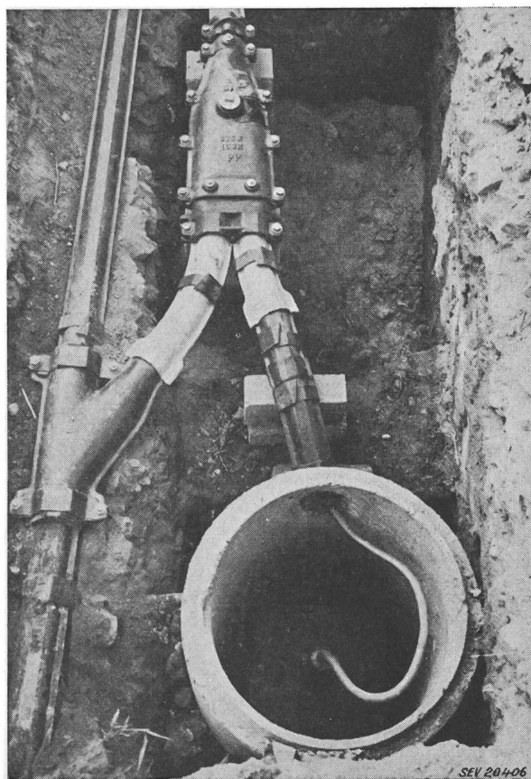
Fig. 1 Fernkabel mit Abzweigmuffe und Pupinschacht
