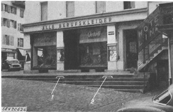
Fig. 12 Unterirdische Station unter einer Treppe 1, 2 Ventilationsöffnungen
