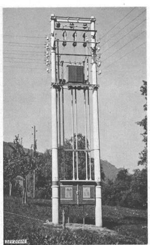
Fig. 2 Stangenstation auf Betonmasten
