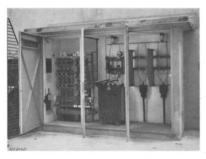
Unter die Stangenstationen kann auch die Anlage in Fig. 4 eingereiht werden; der Transformator ist hier einfach auf den Boden heruntergerutscht. Er weist 1300 kVA auf und dient der Versorgung einer daneben stehenden Grastrocknungsanlage. Diese Lösung ist bemerkenswert.
