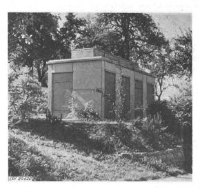
Fig. 6 Kabinenstation aus genormten Elementen
