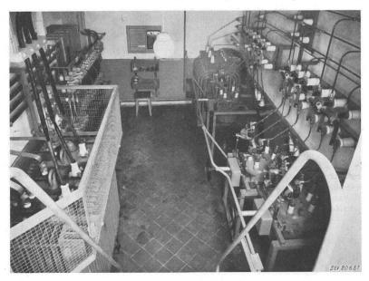
Was könnte vorgekehrt werden, wenn die Transformatorengeräusche stören würden? Liegen Erfahrungen vor über das Aufstellen der Transformatoren auf Gummi, Kork oder Metallgeflecht-Unterlagen oder die Absorption des Luftschalles durch Wandauskleidungen? So viel bekannt ist, wurden mit Pavatexplatten gute Erfolge erzielt; solche Platten
