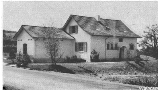
Fig. 16 Anbau einer Station an ein Wohnhaus
