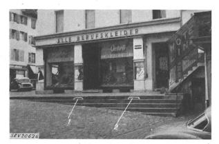
Fig. 12 Unterirdische Station unter einer Treppe 1, 2 Ventilationsöffnungen
