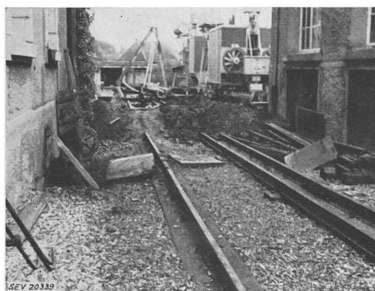
Fig. 9 In der Bildmitte Kabelkanal zwischen Umformer- und Transformatorenstation mit den abgehobenen Abdeckplatten
