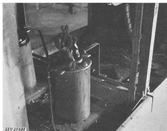
Fig. 8 Zerstörter 16-kV-Ölstromwandler im 1. Stock
