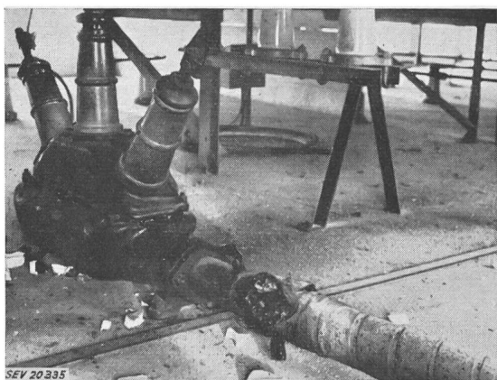
Fig. 5 Endverschluss des 16-kV-Verbindungskabels im 2. Stock der Transformatorenstation Kabel beim Endverschluss explosionsartig zerstört
