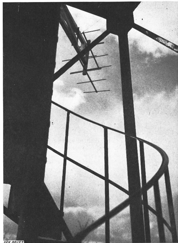
Fig. 15 Link-Empfangs-Antennen auf der Gempenfluh
