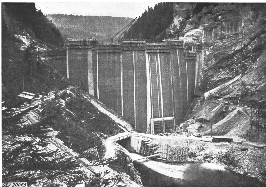
Fig. 6 Staumauer Ansicht von der Wasserseite Bauzustand Juni 1952
