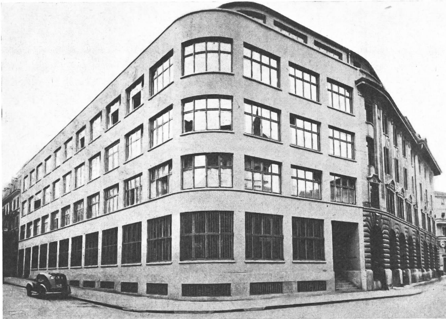
Fig. 2 Gebäude des automatischen Fernamtes Zürich
