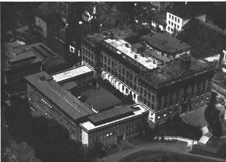
Eidgenössisches Physikgebäude (rechts), erbaut von den Architekten Lasius und Bluntschli im Jahre 1890, mit Neubau der Institute für Fernmeldetechnik und Hochfrequenztechnik (links), entworfen und ausgeführt durch die Architekten F. Metzger und L. Boedecker, 1950 bezogen. Vorn die Gloriamstrasse, im Hof (Mitte) das Cyclotron, rechts oben ein Teil der Versuchsanstalt für Wasserbau
