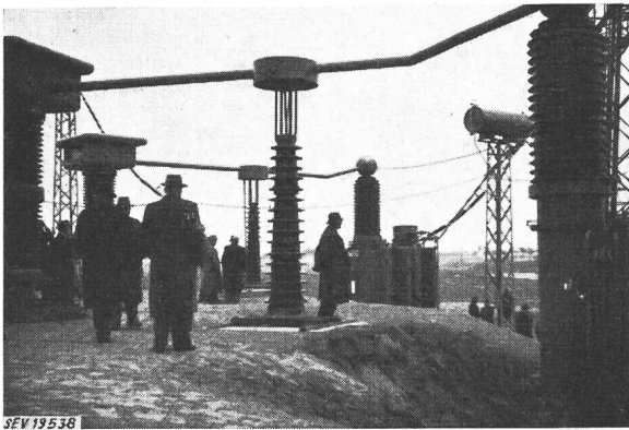
Fig. 1 Besucher in der 400-kV-Forschungsanlage vor Unterspannungsetzung
