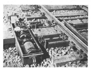
Fig. 1 Elektrischer Weichenantrieb
