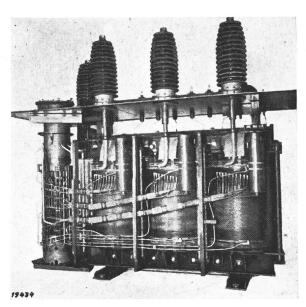
Fig. 3 16-MVA-Reguliertransformator mit Einbauregulierschalter für 110 kV, 250 A,  $\pm$  12 Stufen. Baujahr 1950
