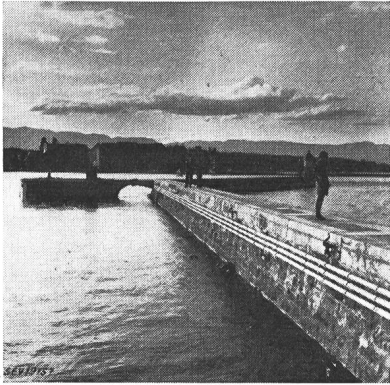
Fig. 5 Câbles électriques le long de la jetée
