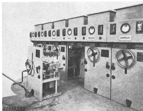
Fig. 2 Ausfahrbare Schalterzelle Anlage Nizza; Baujahr 1931
