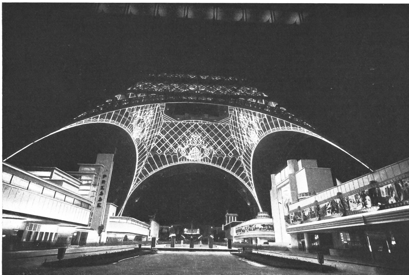
Fig. 1 Dekorative Beleuchtung am Eiffelturm anlässlich der Internationalen Ausstellung in Paris im Jahre 1937 Annähernd 10 000 m Fluoreszenzrohr in weissen Pastelltönen
