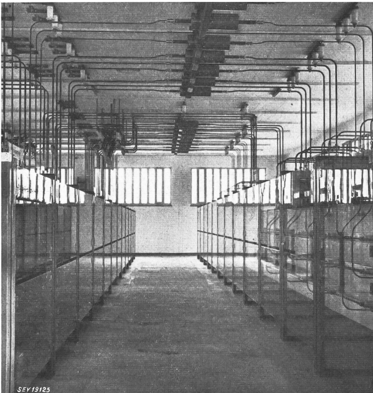
Fig. 7 Zu Revisionsarbeiten verschaltete 16-kV-Zelle
