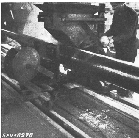
Fig. 2 Isolation d'une conduite d'eau (Zwahlen & Mayr, Lausanne)
