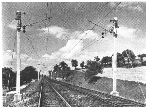
Fig. 3 Fahrleitung der Einheitsbauart der ÖBB Strecke Linz—Amstetten
