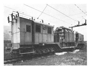
Fig. 4 Fahrbares Unterwerk der ÖBB
