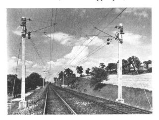
Fig. 3 Fahrleitung der Einheitsbauart der ÖBB Strecke Linz—Amstetten
