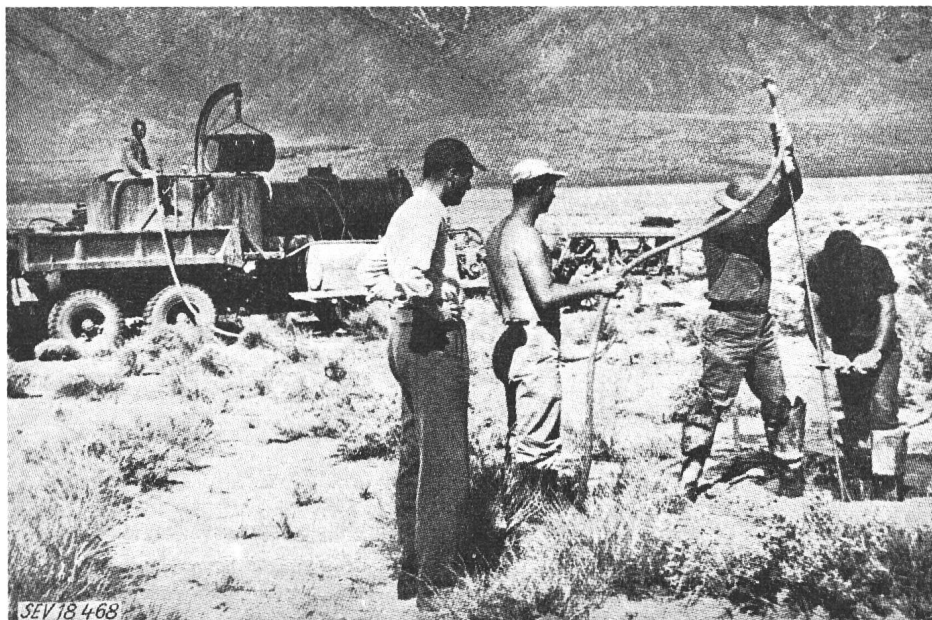
Fig. 1 Das Bodenverfestigungs-aggregat während der Arbeit
