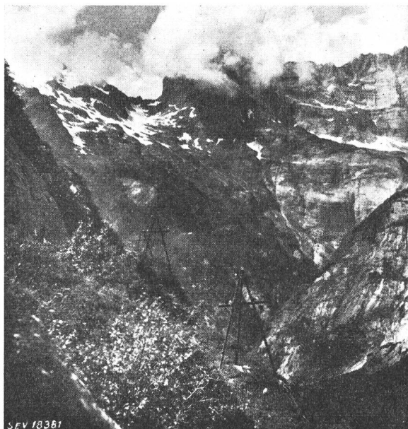
Fig. 1 Dreieck- und Pyramiden-Masten 16-kV-Leitung Innertkirchen-Gauli
