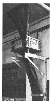
als vollkommen falschstromfrei erwiesen. Fig. 12 zeigt den Kabelringwandler mit den 5 Verbindungskabeln, welcher den Gehäuseschlußschutz eines Generators von 15 200 kVA besorgt, der bei 6 kV mit anderen gleichartig geschützten Generatoren auf ein kombiniertes Kabelund Freileitungsnetz arbeitet. Der kompensierte Erdschlussreststrom schwankt zwischen ca. 0,5 A (bei Gehäuseschlüssen am
