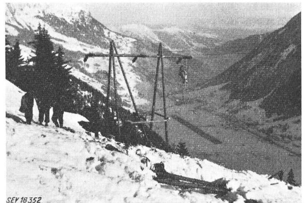
Fig. 11 Gotthardleitung Abspannmast aus Holz an der Unterbruchsstelle bei Mast Nr. 49 oberhalb Piotta
