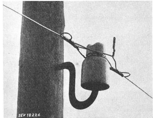
Fig. 5 Fertig geschweisste Verbindung
