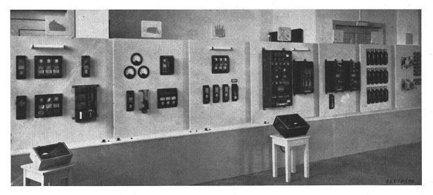
Fig. 3 Von verschiedenen Betriebsgrössen abhängige Schutzrelais zur Steuerung der Schalter
