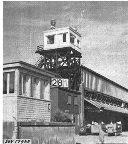
Fig. 3 Der provisorische Kontrollturm, Sitz der Nahzonenkontrolle Auf dem Dach der Drehscheinwerfer. Die Zahlen unterhalb des Turmes bezeichnen die zur Zeit zu benützende Piste
