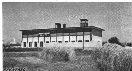
Fig. 2 Das Gebäude der Verkehrskontrolle Oberglatt, von wo der Luftverkehr im Kontrollbezirk Zürich geleitet wird
