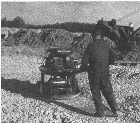
Fig. 7 Verdichten des Kieskoffers mit dem Vibrator
