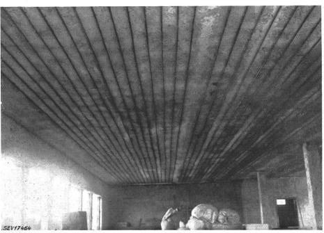
kupfernen Rohre sind mittels Briden festgemacht und die Rohrstösse zum Zweck besserer Wärmeverteilung innerhalb der Decke mit losen, kupfernen Hülsen versehen. Alle Rohre enden innerhalb eines
