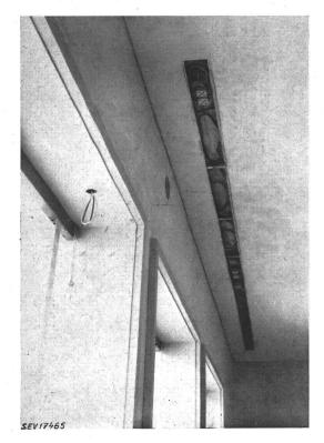
Fig. 3 Schlupfkasten in der Decke zum Einziehen der Heizkabel
