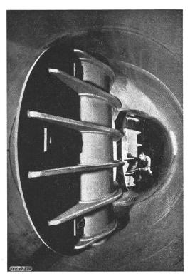
Fig. 4 Verschlussorgane des Druckstollens der Hauptstufe
