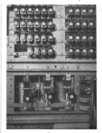
Fig. 1 Teil eines Relais-Schrankes oben: elektromagnetische Telephonrelais
