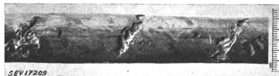
Fig. 9 Câble corrodé par électrolyse
