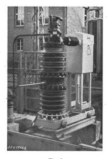
Fig. 2 Ölstrahlschalter mit Federkraftspeicherantrieb, eingebaut als Fahrleitungs-Speisepunktschalter im Unterwerk Grüze der SBB
