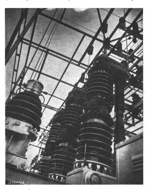
Fig. 4 Ölstrahlschalter 60 kV
