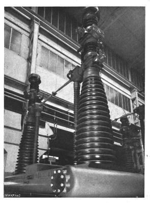
Fig. 2 Luftdruckschalter 220 kV
