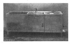
Links Spültrog ohne Heizung. Wasserschiff mit Heizstäben unten in der Maschine. Schwenkhahn zum Füllen der verschiedenen Tröge. Gehäuse der Maschine aus Blech. Der Klemmenkasten der Maschine ist für Rohranschluss eingerichtet.
