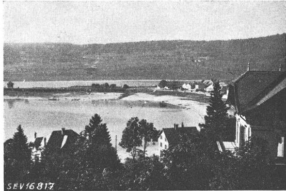
Fig. 7 Le Pont mit Lac de Joux und, im Hintergrund, Lac Brenet Der tiefe Wasserstand gibt Uferpartien frei, die Plages gleichen
