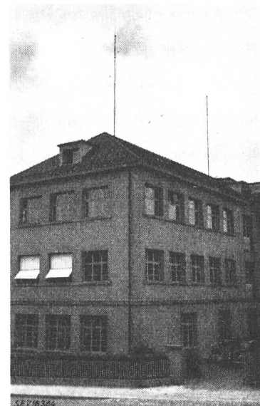
Fig. 12 Telephonzentrale Riedtli Auf dem Dache die Sende- und Empfangsantenne
