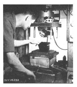
Fig. 2 Pressen des Isolierstoffgehäuses eines Telephonapparates
