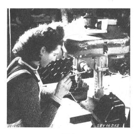
Fig. 3 Verputzen des fertig gepressten Gehäuses des Telephonapparates
