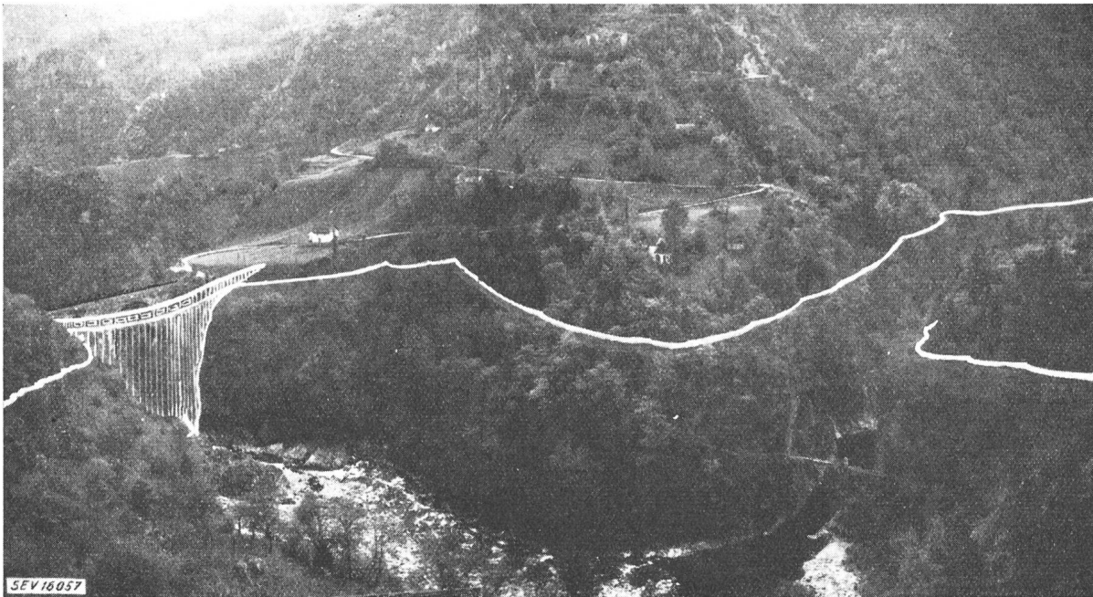
Fig. 6 Staumauer und Ausgleichbecken Palagnedra
