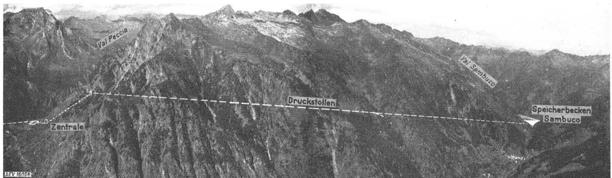
Fig. 7 Kraftwerk Peccia links: nach dem Kraftwerk Cavergno
