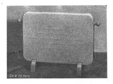
hebel-Regulierschalter vorhanden. Handgriffe aus Holz, Füsse aus Metall. Versenkter Apparatestecker für den Anschluss der Zuleitung.
