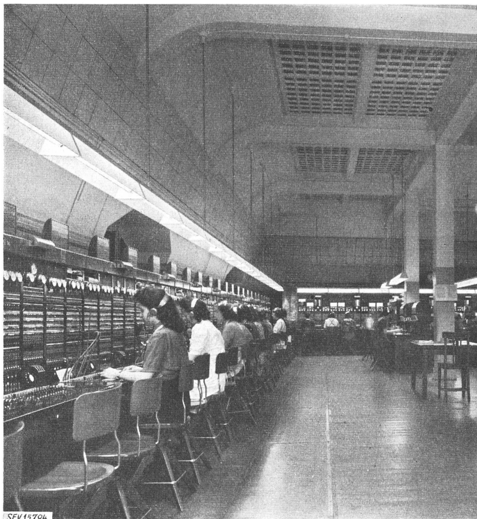
Fig. 5 Fernamt mit Fluoreszenz-Lampen Diffusoren mit opaleszenten Seitenflächen. E_m = 300 \text{ Lux} .
