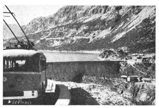
einander aufweist. Diese Strecke wurde während des Krieges gebaut. An Stelle der Fahrleitung aus Hartkupfer wurde hier ein mit Stahldrähten armiertes Aluminiumprofil verwendet.
