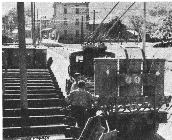
Fig. 14 Umladevorrichtung Eisenbahn—Trolleybus im Oberveltlin Das Abladen leerer Zementbehälter vom Trolleybus auf die Laderampe erfolgt in gleicher Weise ohne jegliche Hebezeuge
