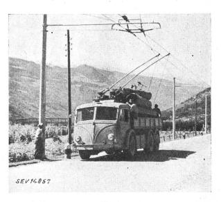
Fig. 9 Personen- und Güter-Trolleybus im Oberveltlin (Italien) Güter-Trolleybus für Langholztransport
