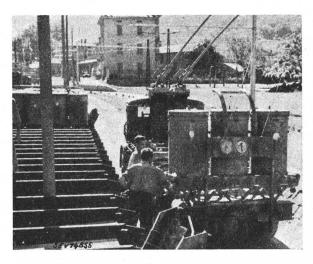
Fig. 14 Umladevorrichtung Eisenbahn—Trolleybus im Oberveltlin Das Abladen leerer Zementbehälter vom Trolleybus auf die Laderampe erfolgt in gleicher Weise ohne jegliche Hebezeuge
