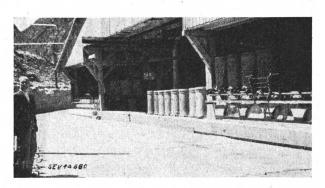
Fig. 17 Abladestelle für den Güter-Trolleybus im Oberveltlin Talstation der Seilschwebebahn, welche die einzelnen Behälter für Zement und Bruchsteine bis zu einer hoch gelegenen Baustelle fördert
