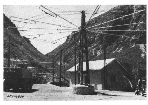
Fig. 18 Güter-Trolleybus an der Stelvio-Strasse (Oberveltlin)
